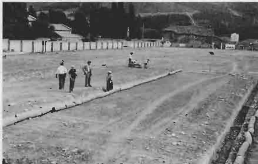
1978. El drenaje del Campo. Tubos nuevos para Santo Cristo.
