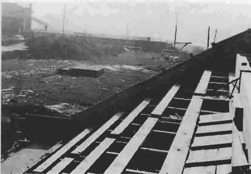
1978. La nueva tribuna de Santo Cristo en construcción.
