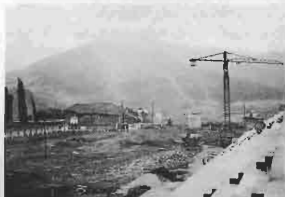
1977. Comienzo de las obras del nuevo Santo Cristo.
